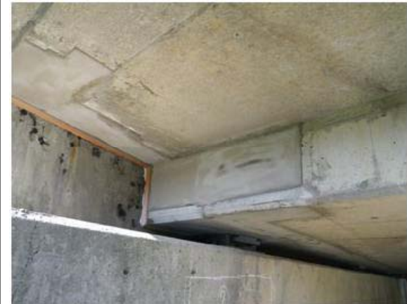
桁端部の断面修復
