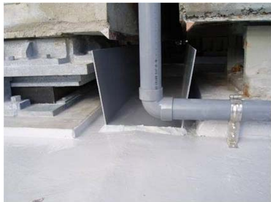
桁端部漏水対策
